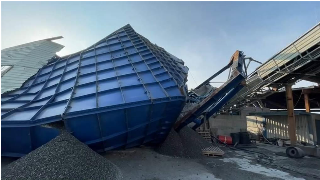
圖2-13 志昇砂石場砂石大桶倒塌災情
