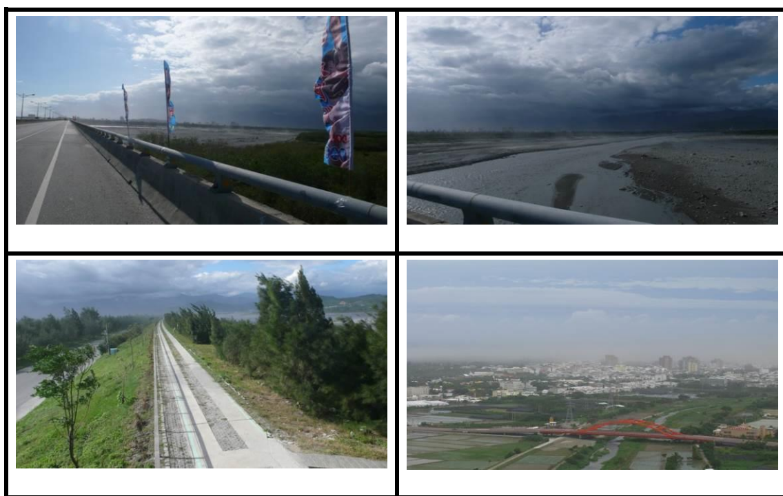
圖 2-20 臺東縣塵暴災害照片
