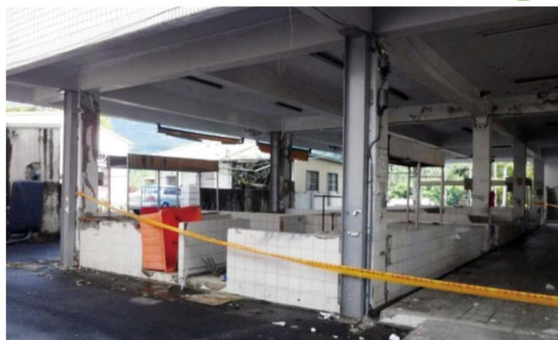
某公有市場於2016年美濃地震前已施作簡易補強，地震時明顯發揮抗倒塌效果。
